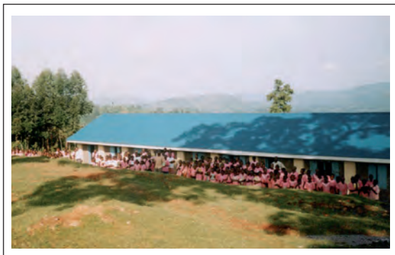
4-Klassen Grundschule mit Lehrerzimmer, Bücherei, 2 Büros, Küche und Lager in Bumumali (Uganda)
