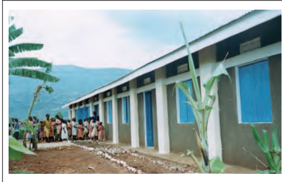
4-Klassen Grundschule mit 2 Lehrerwohnungen, Küche und Lager in Bumbo (Uganda)
